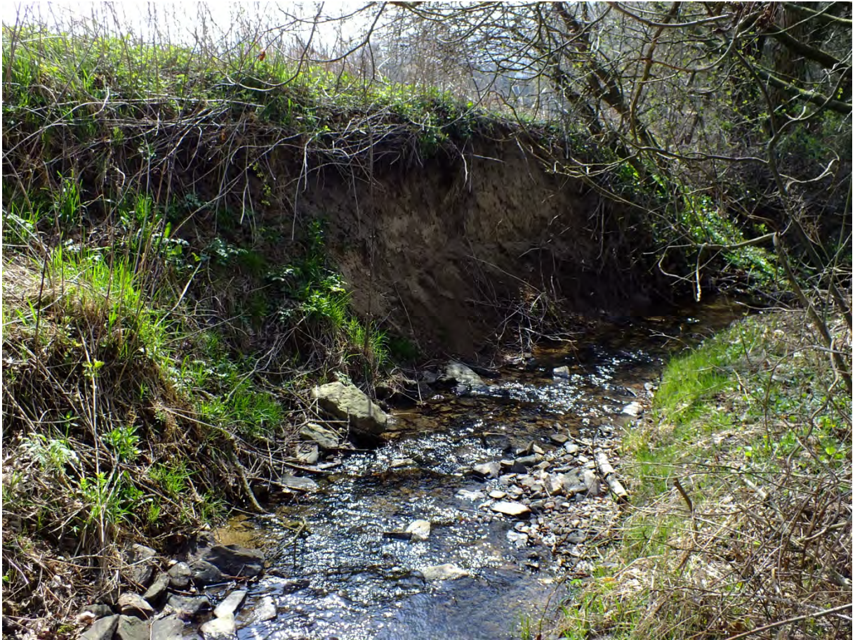
Abbildung 4: Namenloser Bachlauf mit starker Seitenerosion und Uferabbrüchen
